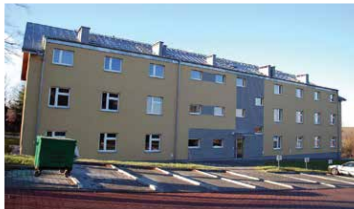
Nowy blok z mieszkaniami socjalnymi przy ul. Wiślańskiej.
