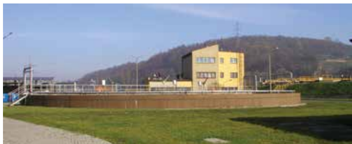
Zmodernizowana oczyszczalnia ścieków.
