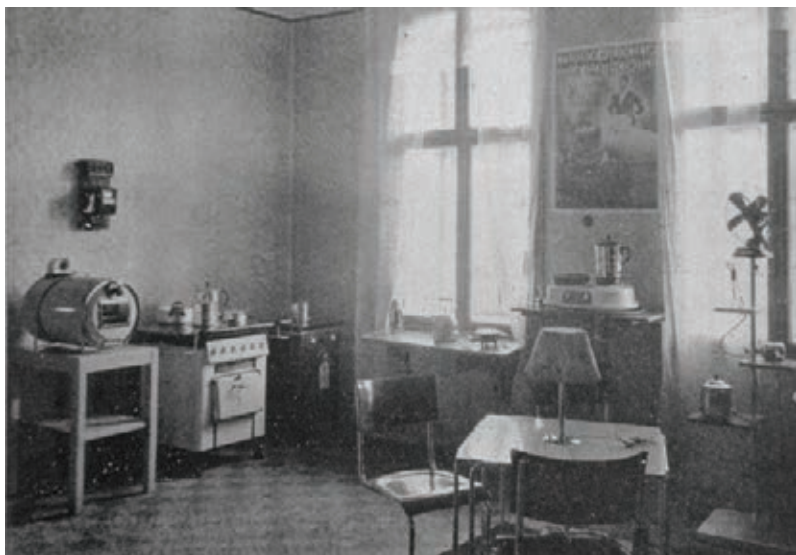
Lokal propagandowy Elektrowni Okręgowej Miasta Cieszyna, fot. z lat 30. XX w. z Budowa i rozwój Elektrowni Okręgowej M. Cieszyna
