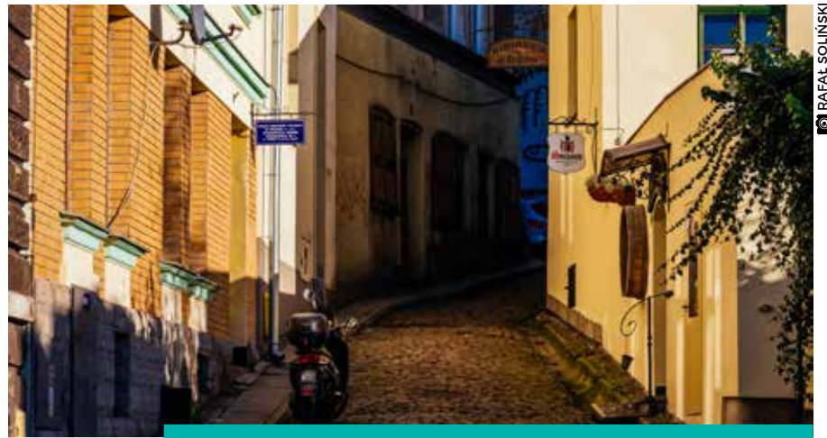
W 2021 roku zaplanowano m.in. środki na przebudowę ul. Trzech Braci.
