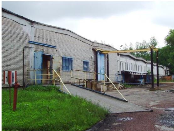
Rampa z suwnicą
